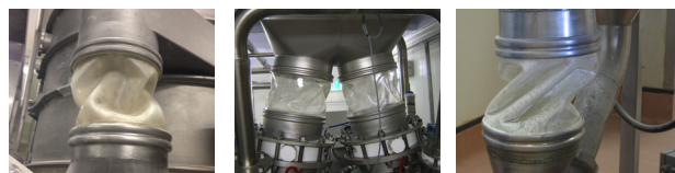
Příliš malá instalační mezera
